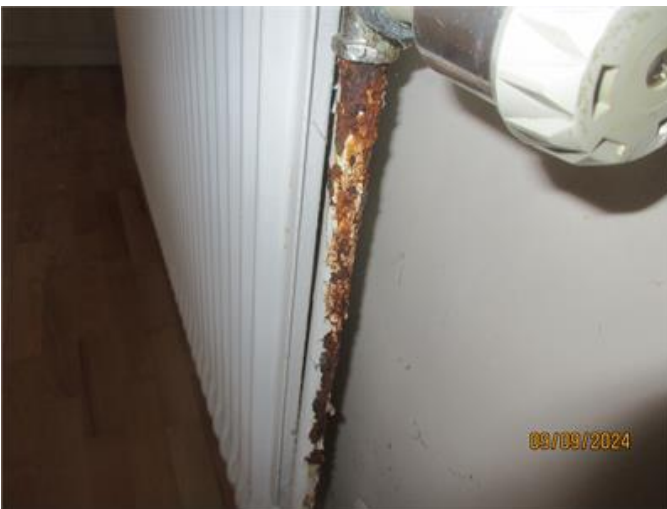
Rostangrepp på rör till element.
