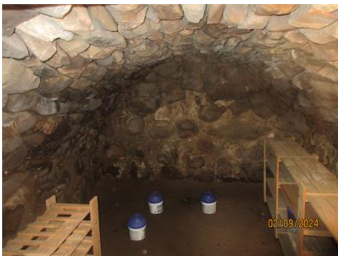
Mindre förråds/matkällare med betonggolv, se kommentarer och riskanalys.
